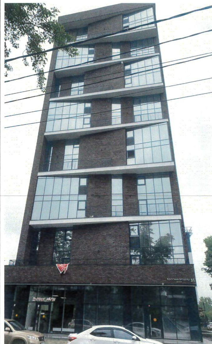
Главный фасад в осях Г-А
