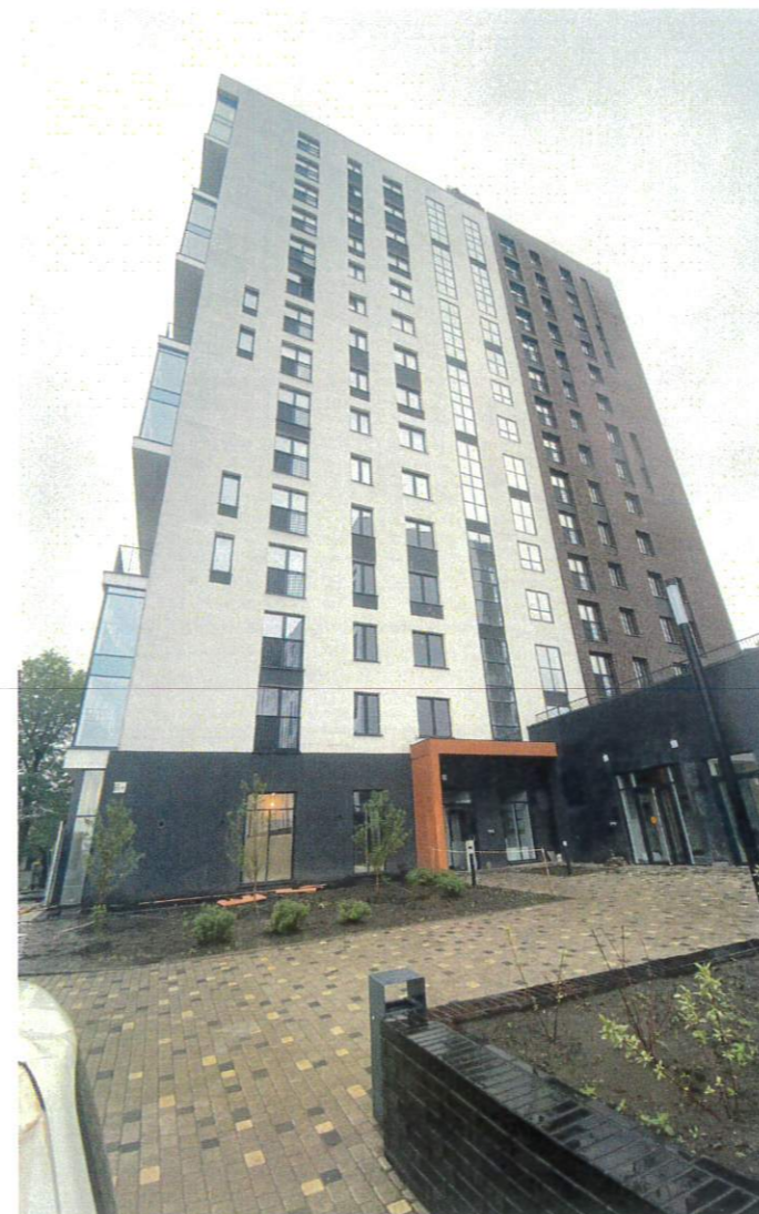
Боковой фасад в осях 6-1
