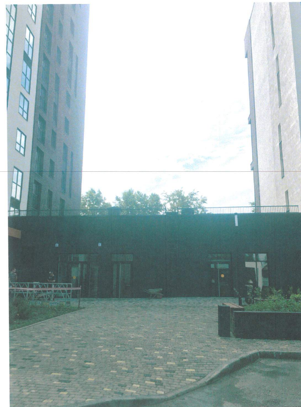
Дворовой фасад в осях 15-12
